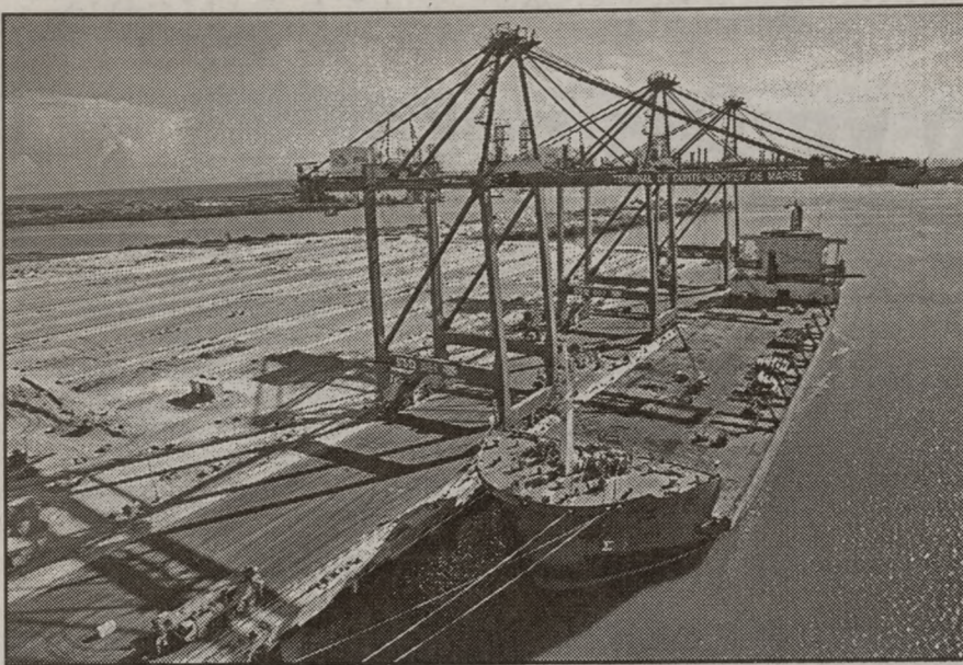
Vista del muelle, en construcción, de la terminal de contenedores. Nótese, abajo a la izquierda, el tamaño de la grúa de camión, comparado con el de las grúas junto al barco.
